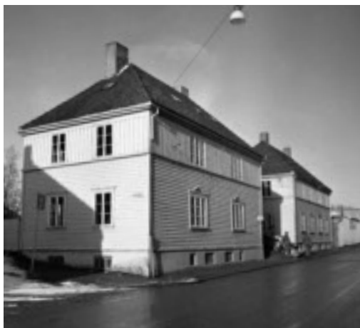
Dette var de to siste bolighusene som Stavanger kommune bygde. De lå i Steinhagen, på hjørnet av Haugesundsgata og Nærbøgata. Bildet ble tatt kort tid før husene ble revet i 1983. Foto: Stavanger byarkiv
