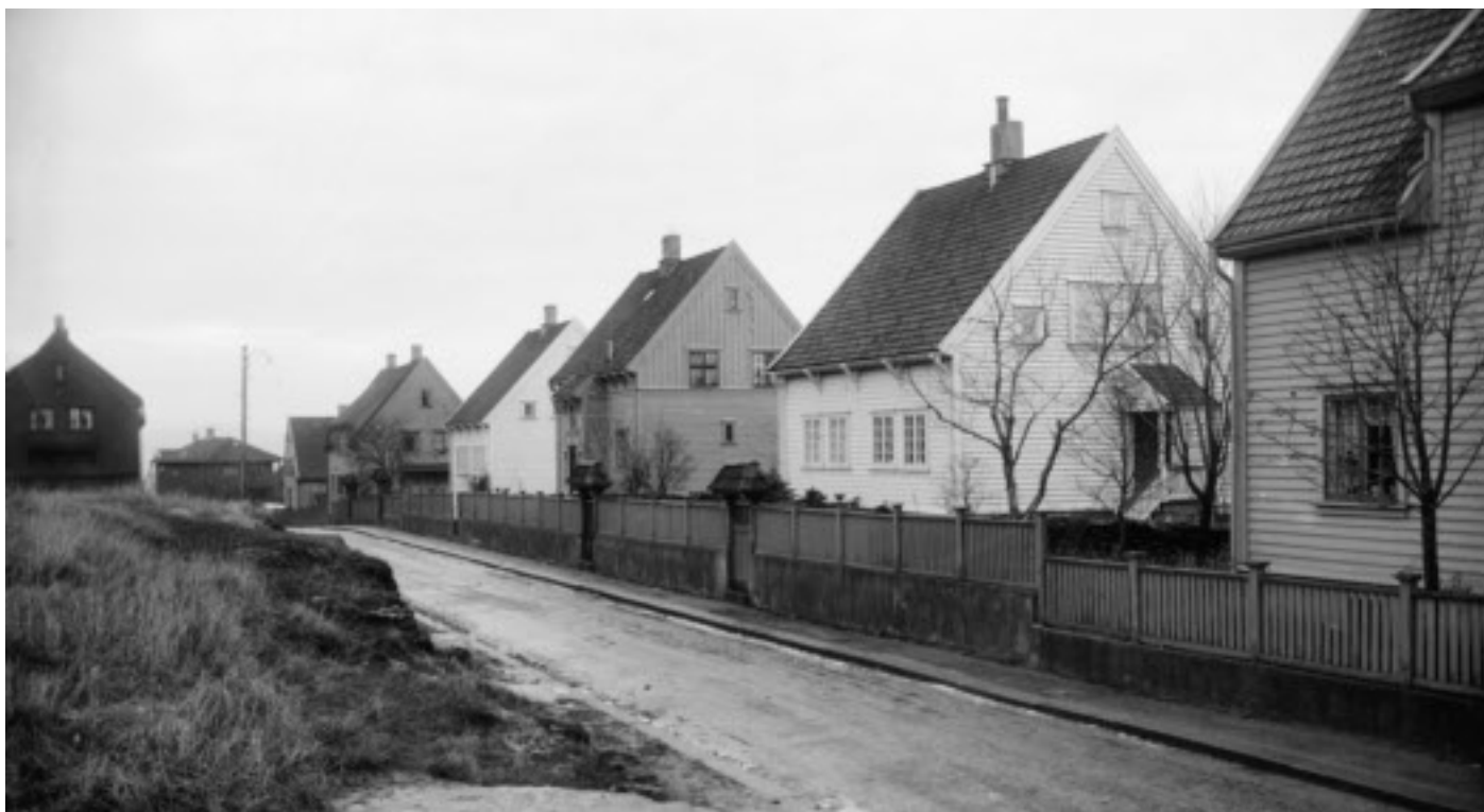
Tomannsboliger på Våland., Friggsgt. Husene var påvirket av boligreformbevegelsen og var vertikaldelte. Det var uvanlig i Stavanger på den tiden. Bildet er tatt ca. 1920. Foto: Stavanger byarkiv
