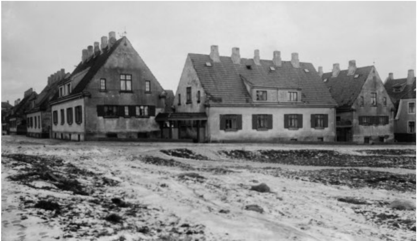
Kommunegårdene på Eiganes fotografert på 1920-tallet. De bærer allerede preg av forfall. I dag er både skorsteiner, skodder og portaler borte. Disse særpregete husene bør rehabiliteres etter stadsarkitektens tegninger. Foto: Stavanger byarkiv
